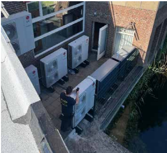
De laatste afwerking van het dak & warmtepompen
